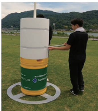
⑧ 固定バンドで 仮固定を行って下さい ※必ず2巻きで固定
