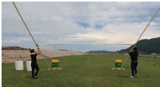
⑥ ③で組み立てたポールを持ち上げ、タンク中央にまっすぐ挿し込む ※風が強い日などは、補助人がいる方が安全です。
