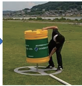
④ 基盤に下部ドラムを挿し込む ※基盤の芯が中央にないと支柱が スムーズに挿し込めません。
