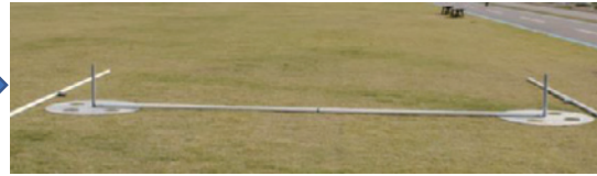
② ゴールポストの長さを確認し、 基盤ボールの内々の長さに合わせて位置を決めて下さい。
